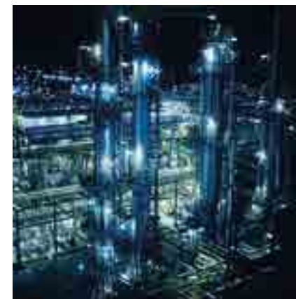
PCK Raffinerie in Schwedt
