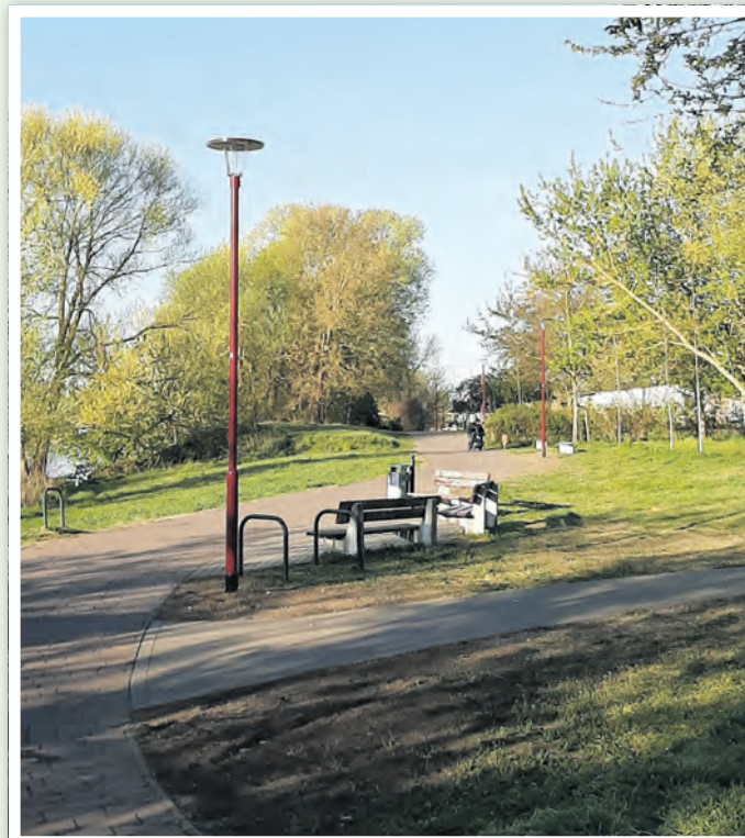
Am Uferradweg vom Jugendufer bis zum Holzhafen errichteten die Stadtwerke zwölf neue LED-Leuchten.
