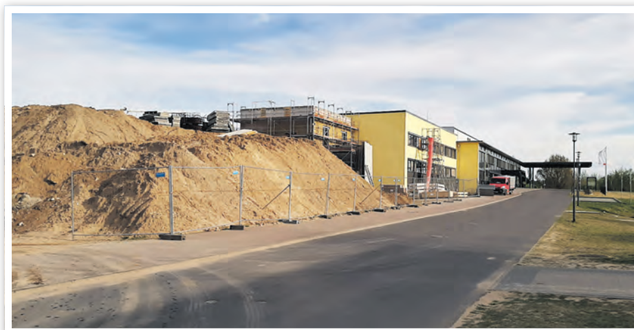
Baustelle: Hubschrauberlandeplatz und Notfallambulanz im April 2020
