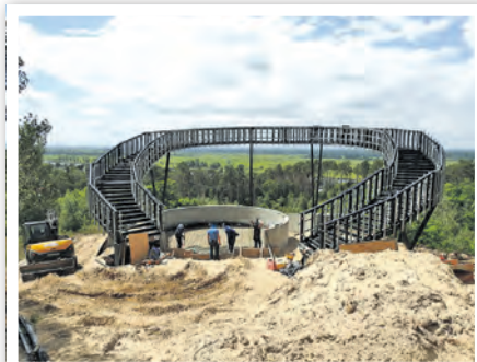
Baustelle Aussichtsplattform in Widuchowa
