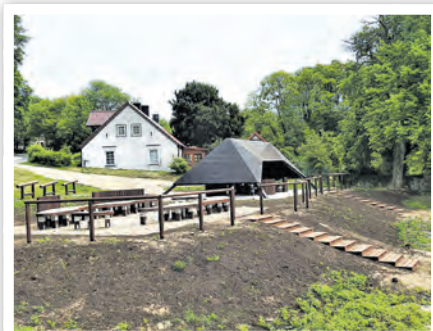
Baustelle Naturrastplatz in Gozdowice
