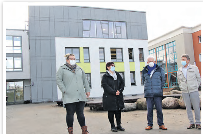
Offizielle Übergabe des fertigen Anbaus
