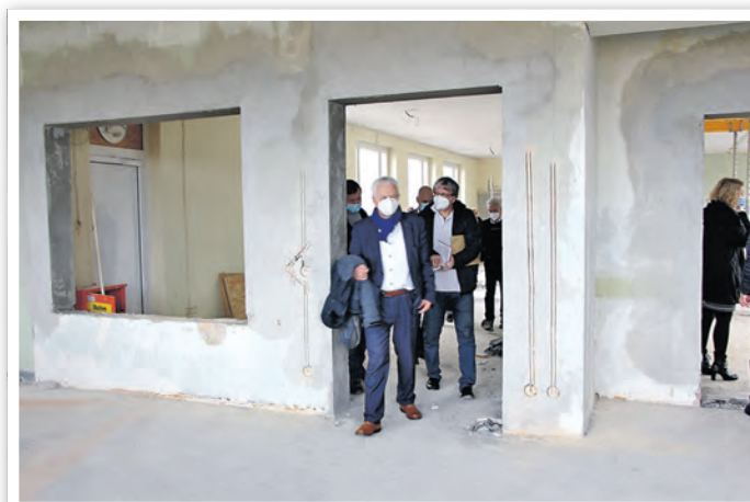
Baubegutung im Altbau
