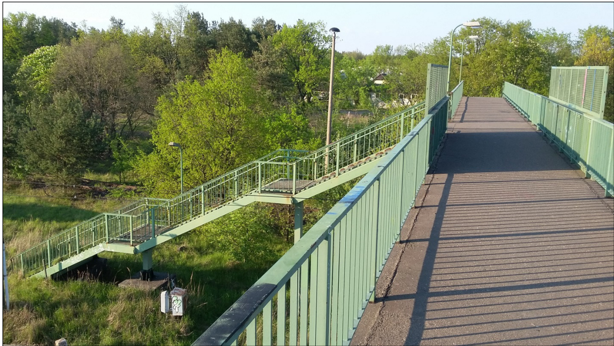
Abbildung 3: Blick auf den westlichen Abgang der Fußgängerbrücke
