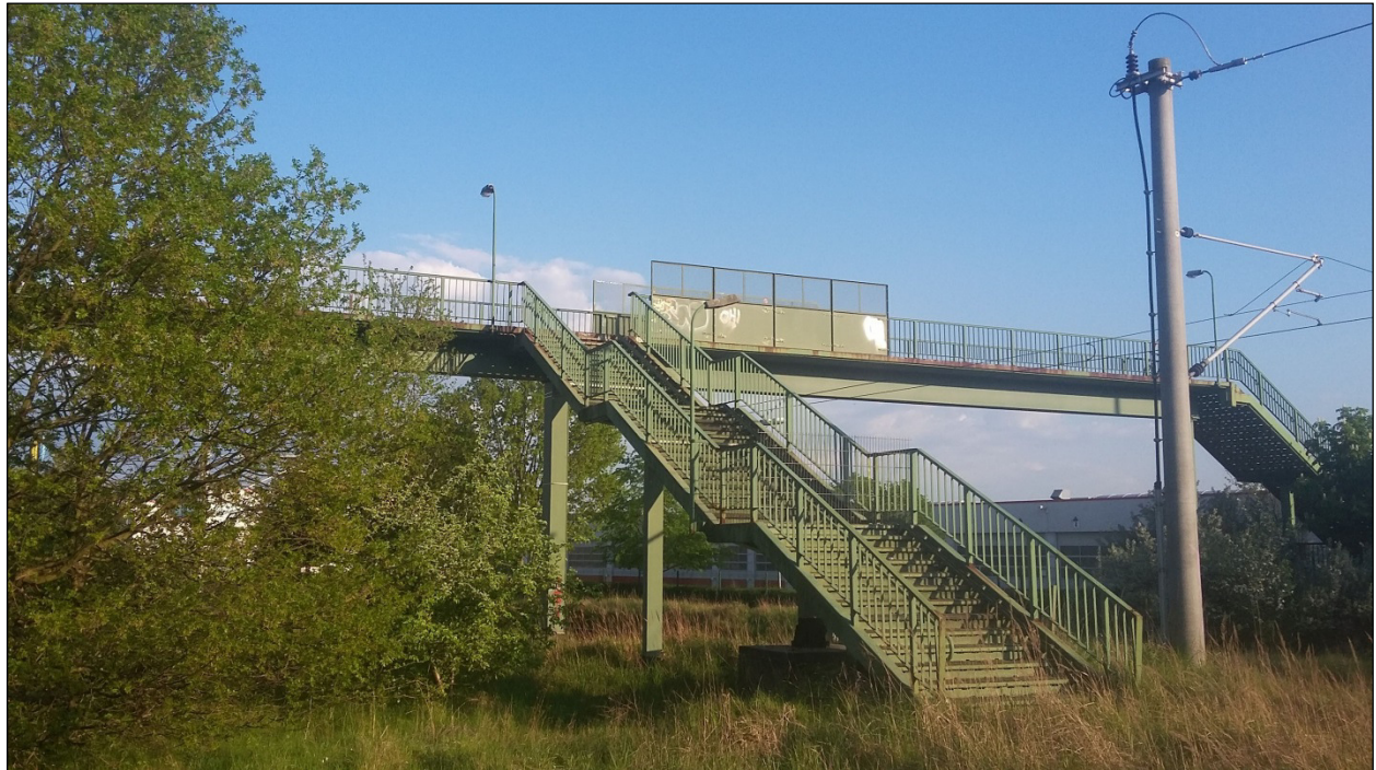
Abbildung 1: Ansicht der Fußgängerbrücke von Nordwesten
