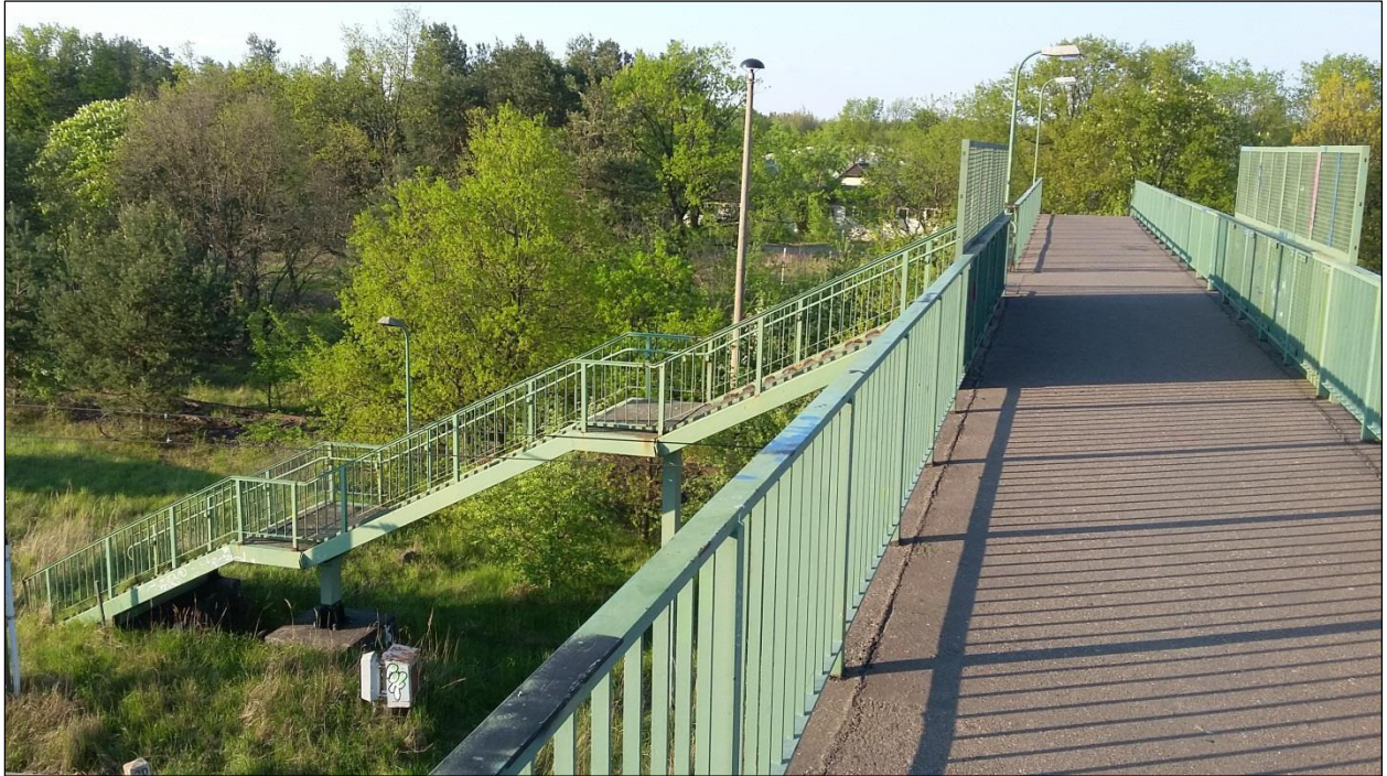
Abbildung 3: Blick auf den westlichen Abgang der Fußgängerbrücke
