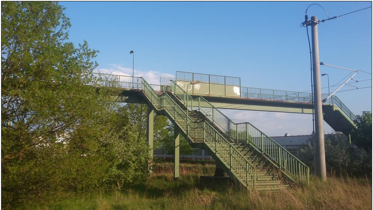
Abbildung 1: Ansicht der Fußgängerbrücke von Nordwesten
