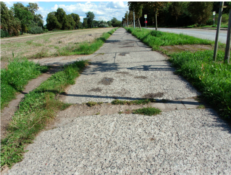
Absenkungen, Dellen und Pflanzenbewuchs auf der Fahrbahn stellen eine Gefahr da!
