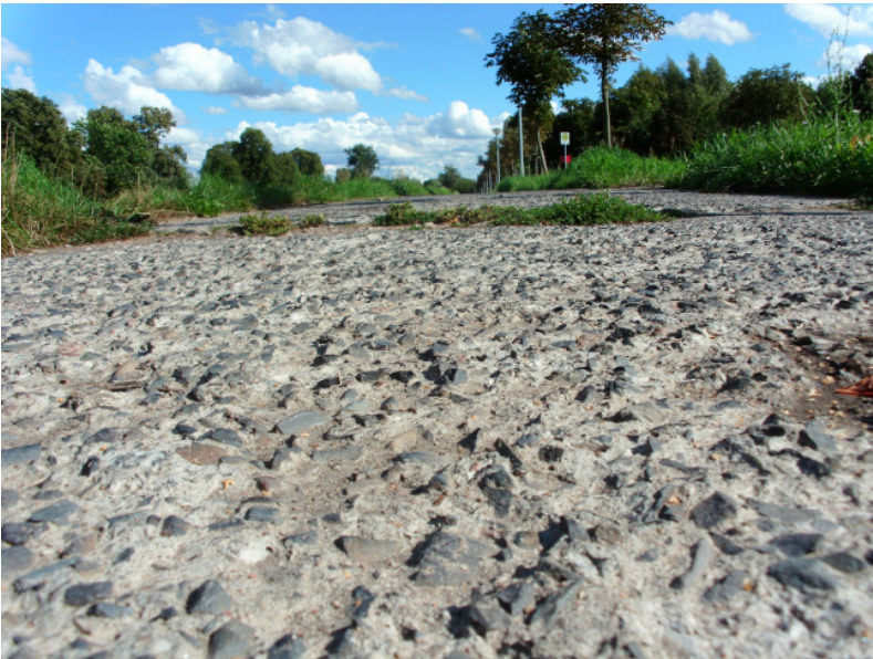
Absenkungen, Dellen und Pflanzenbewuchs auf der Fahrbahn stellen eine Gefahr da!
