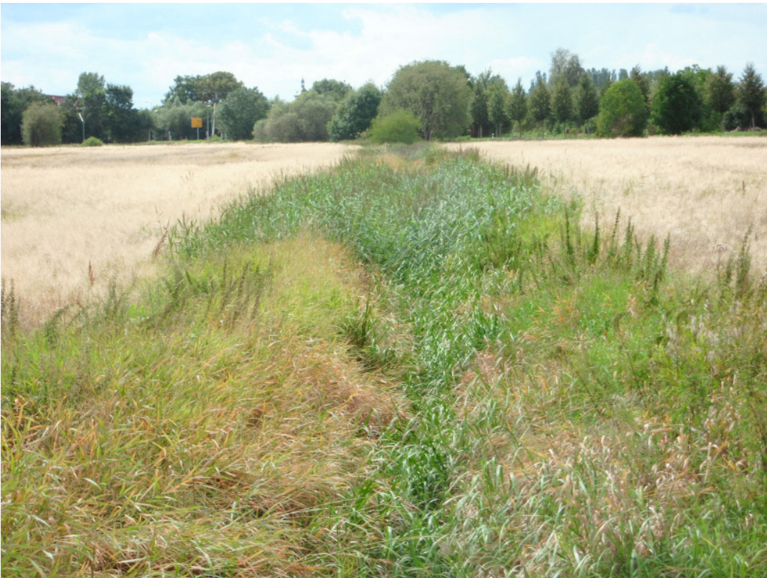
Der Landgraben ist zugewachsen, er muss kurzfristig ausgebagert werden, damit das Schichtenwasser im Graben wieder abfließen kann.
