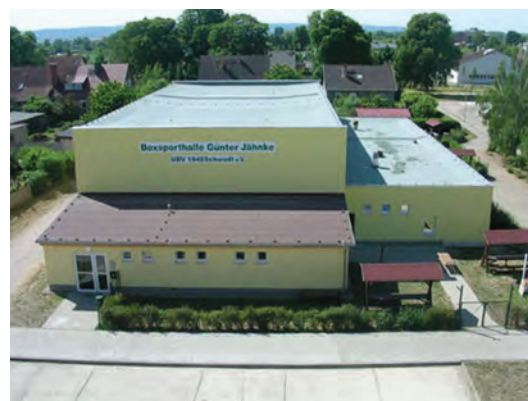
Abb: Boxhalle des UBV 1948 (Effenberger)
