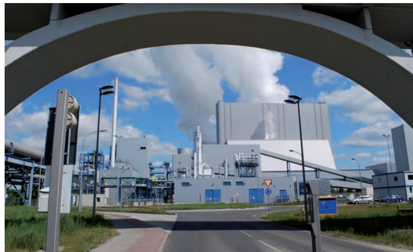
Im September 2008 wurde die weltweit erste Oxyfuel-Pilotanlage für eine klimafreundliche Braunkohleverstromung in Betrieb genommen.
