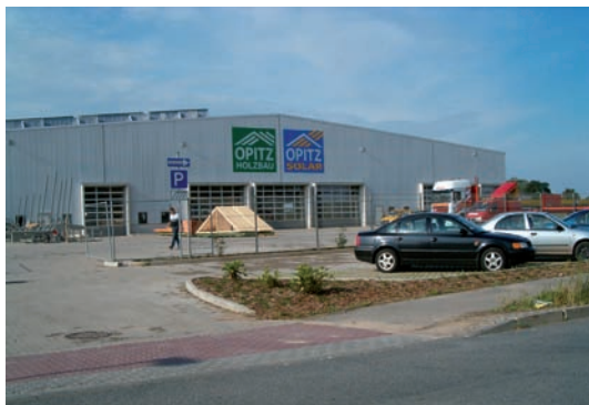
Neubau Opitz Holzbau GmbH & Co. KG.
